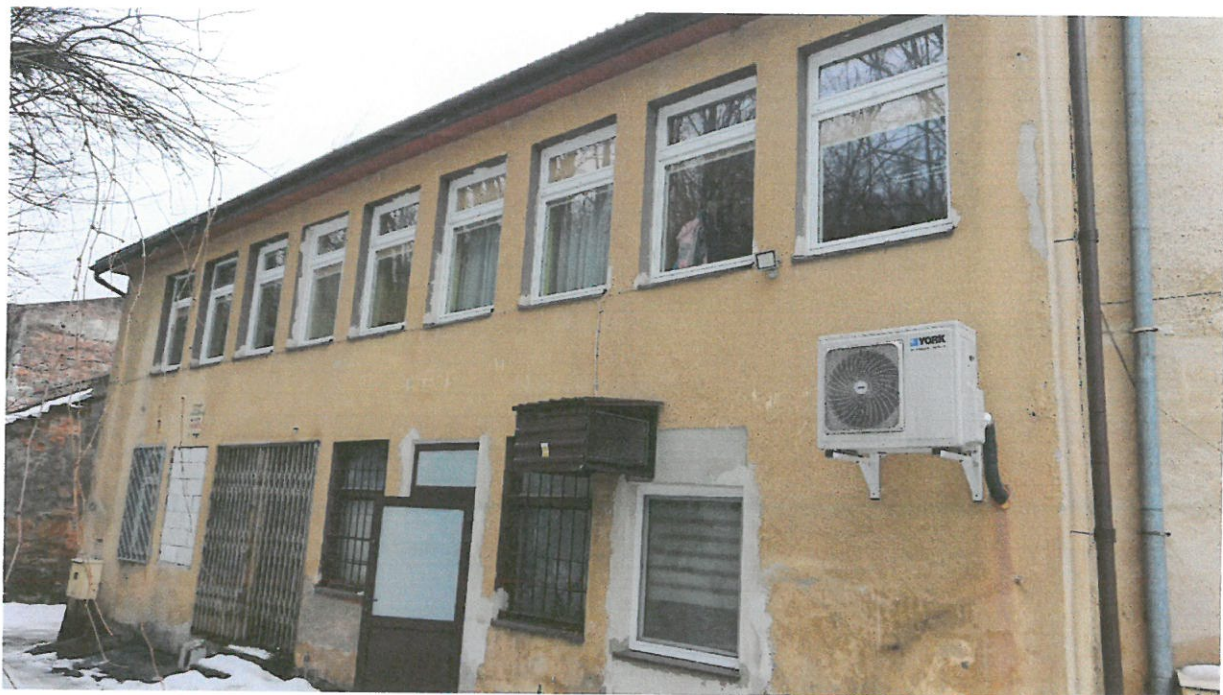
Zdjęcie nr 3 – Elewacja boczna
